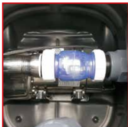
Rückschlagventil RSK und Entleerungspumpe
